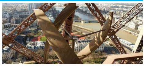
l'eolico. Infatti al secondo piano della "dama di ferro" sono state installate due turbine eoliche che garantiranno una cospicua parte del Fabbisogno energetico della torre.
